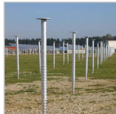
Bild 7: Schraubenfundamente kurz vor dem Eindrehen.
